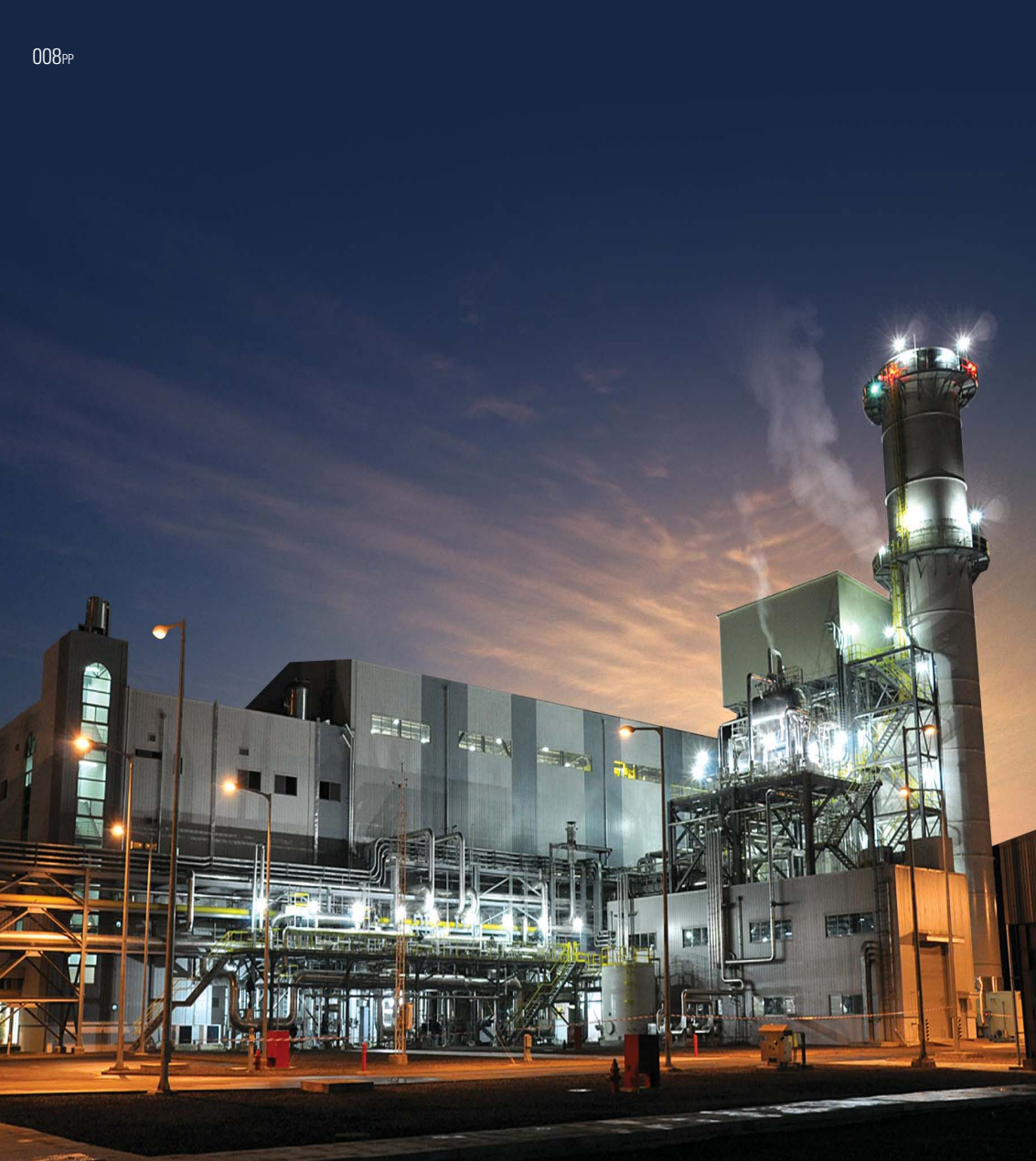
008PP Yerevan CCPP 위치: 아르메니아 - 복합화력발전: 230MW - 가스터빈(167MW 17기) - 스팀터빈(63MW 17기) 공사기간: 2007. 12 ~ 2010. 04
